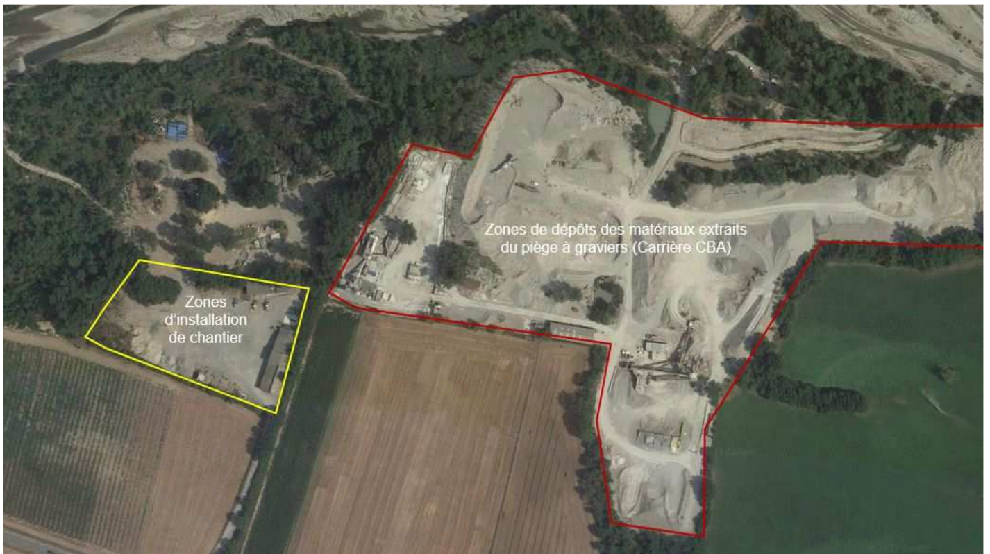
Installations de chantier et zones de dépôts des matériaux extraits du piège à graviers au niveau de la carrière CBA
